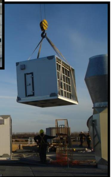
Foto derecha: izaje de módulos de UTA; foto superior; UTA armada en posición.
