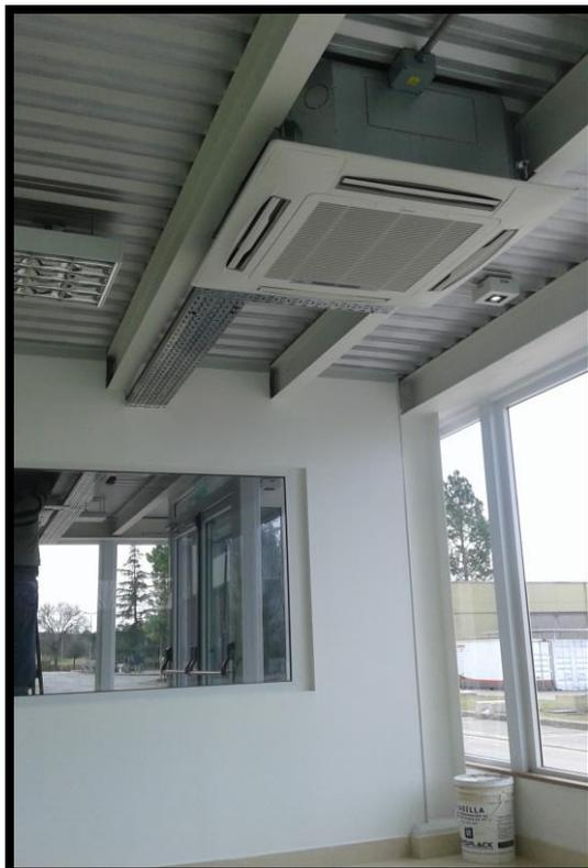
Sistema de aire acondicionado VRF; para ampliación oficinas C05, de 70 TR y 27 evaporadoras cassette o de ductos.
