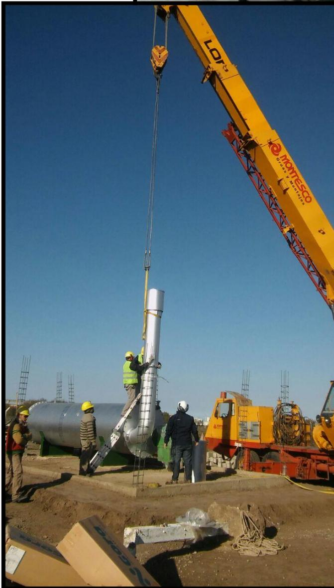
Foto izq: montaje de chimenea, intercambiador
