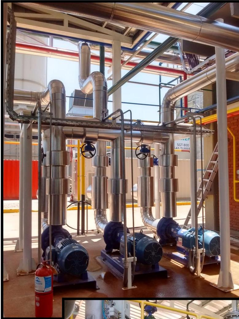
**Foto izq:** Sistema de bombeo de agua fría; 2 bombas base y 1 de reserva.
