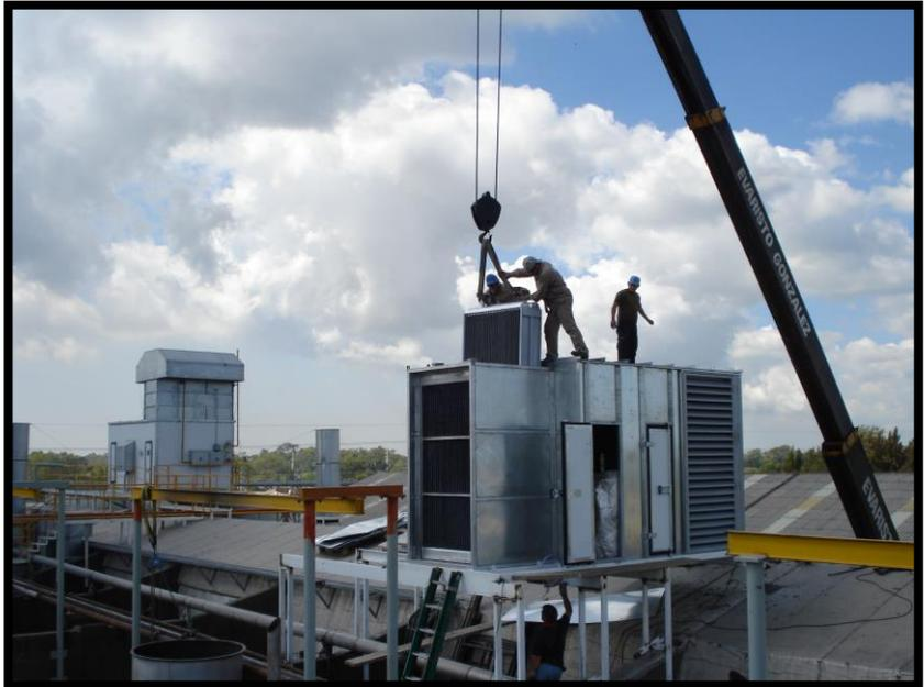
Foto: Montaje de UTA y serpentinas de vapor.
